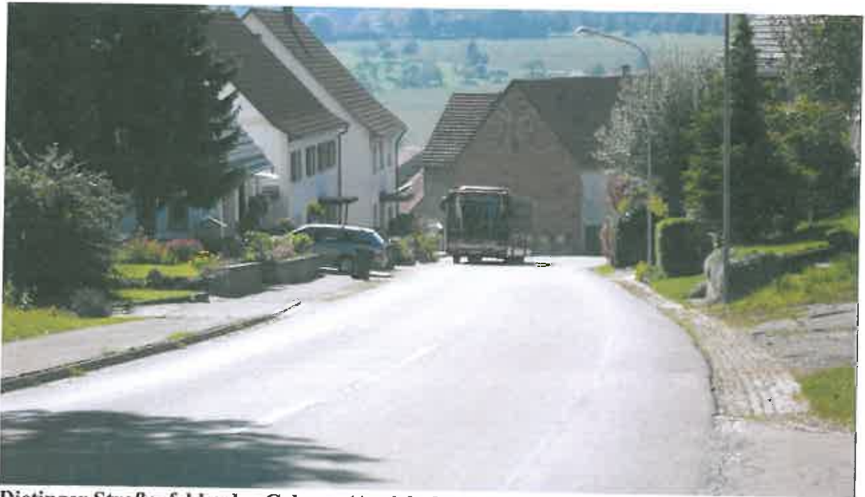
Dietinger Straße, fehlender Gehweg (Ansicht bergab Richtung Süden)
