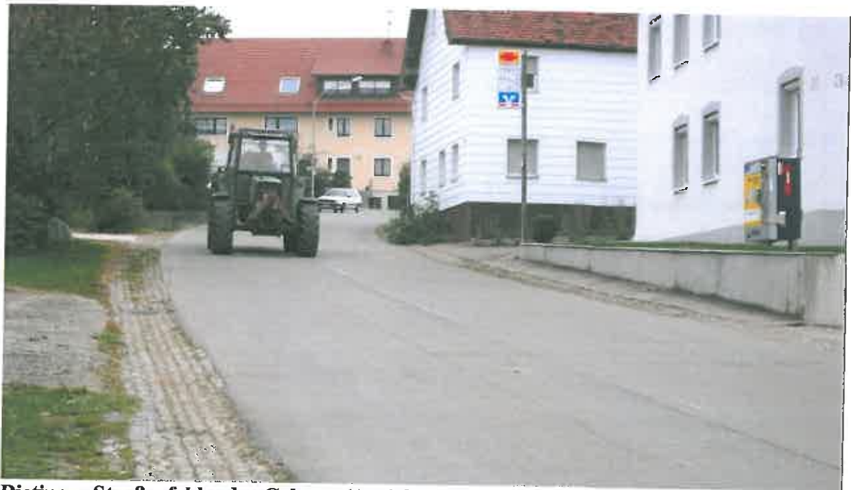
Dietinger Straße, fehlender Gehweg (Ansicht Richtung Norden)
